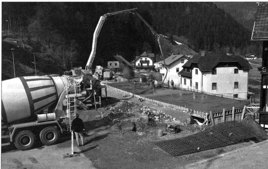
Vlivanje betonske plošče na pokritem parkirišču (foto: arhiv Občine Luče)
