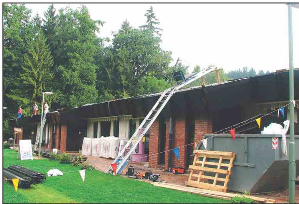
Vrtec Tinkara je dobil novo streho. Sedaj ne bo več teklo in zamakalo.
