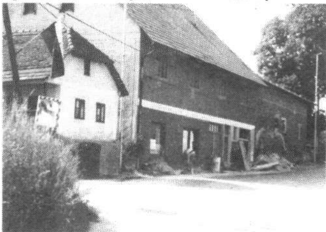
In vendarle se nekaj dogaja – v tej hiši bo po končani obnovi Agrokombinatova mesnica, v stavbi, ki se je drži, bo menda zasebnik uredil gostinski lokal. Iz teh prostorov se je slišalo razbijanje orodja tudi tisto soboto, ko je bil v Leskovcu praznik.
