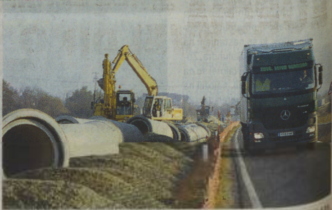
Odsek Lendava–Pince, skupaj s hitro cesto do mejnega prehoda Dolga vas, dolžina 16,5 kilometra. Delavci so že začeli širiti lendavsko obvoznico, smeri proti mednarodnemu mejnemu prehodu Dolga vas zgrajena kot hitra cesta.
