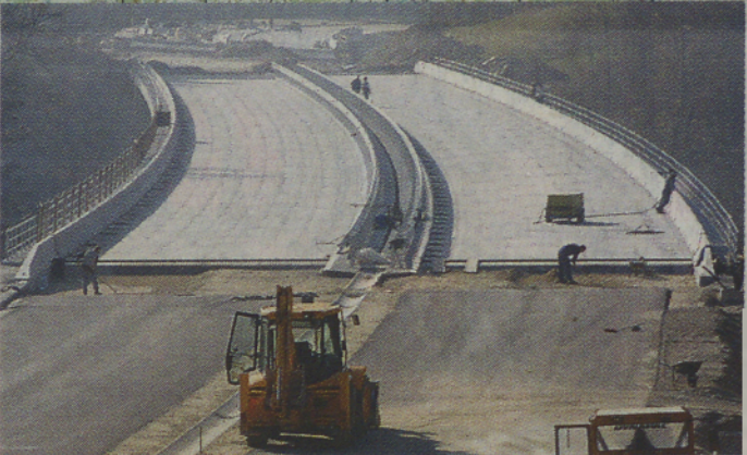
Na odseku od Cogetincev do Vučje vasi bo zgrajenih kar 43 različnih objektov, med njimi štiri viadukti. Na fotografiji je viadukt čez dolino Stanetinskega potoka, ki je dolg 256,43 metra.
