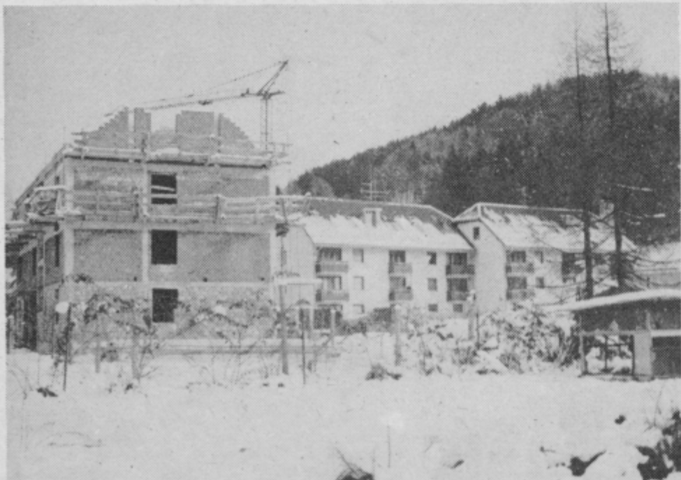
Poleg dveh novih blokov rasejo že nova stanovanja. Močno jih potrebujejo.
