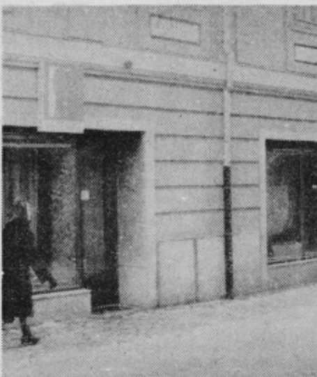
Pogled na pročelje preurejene VEZENINE
