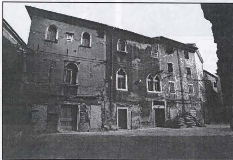
La futura sede della Comunità
