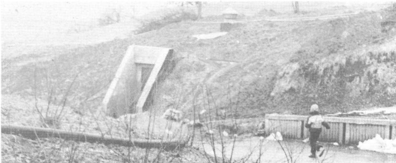
Trenutno motiv za fotografa ni posebno zanimiv. Betonski vhod, zračnik, sveže nasuta zemlja. Za vse to pa je bilo nekaj sto ur delovnih Dobrovčanov oktobra in novembra lani. Izgradnja črpalne postaje s 15 kubičnim rezervuarjem pa je predzadnja stopnja pri dokončni ureditvi oskrbovanja Dobrove z vodo
