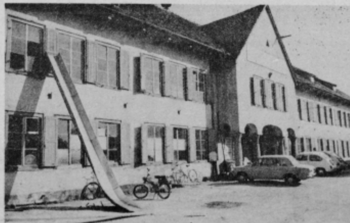
Tudi osrednja zgradba delovnega kolektiva je potrebna temeljite obnove in prostorske preureditve.
