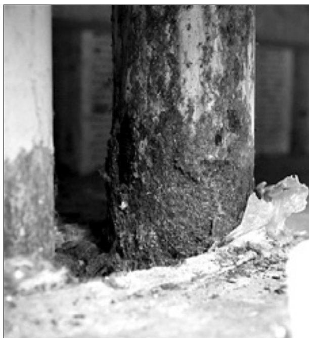
Gnile cevi za ogrevanje v balonu (levo) in kritičen primer plesni v slačilnicah (desno)
