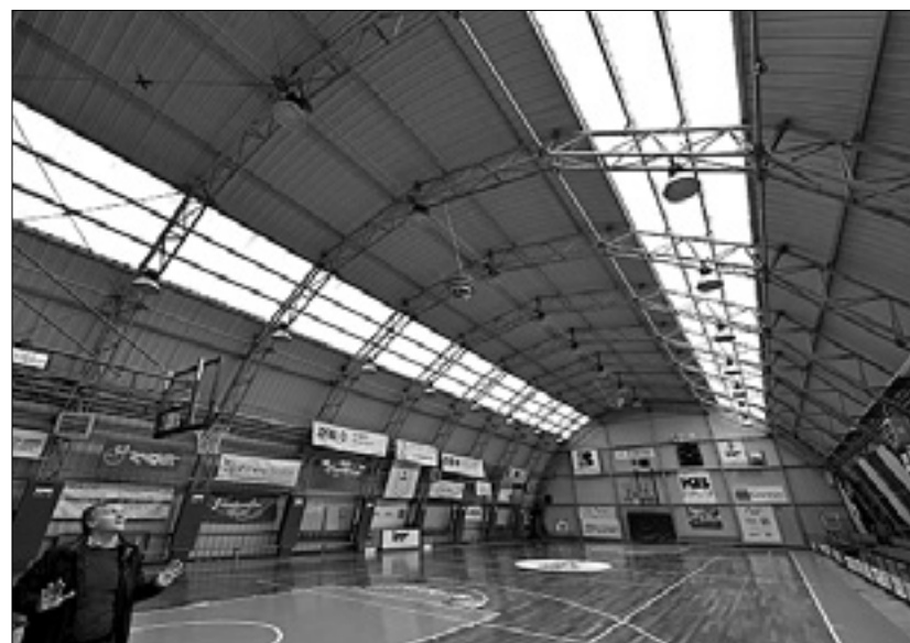
Centralni del strehe v balonu je gnil, tako da bo streho treba na novo prekriti FOTODAMJ@N
