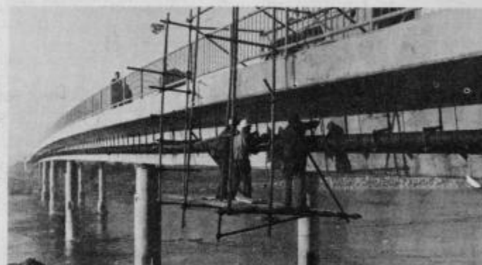
Tu je pred 8 meseci povezoval bregove Drave dotrajni leseni most, danes pa se v elegantnem loku vzpenja nov armirano betonski most s skupno dolžino 183,9 metra. Foto: M. Ozmec
