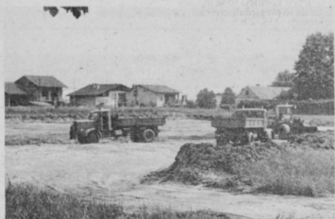
Ob Ormoški cesti so se že začela prva zemeljska dela (foto: z. Kodrič)
