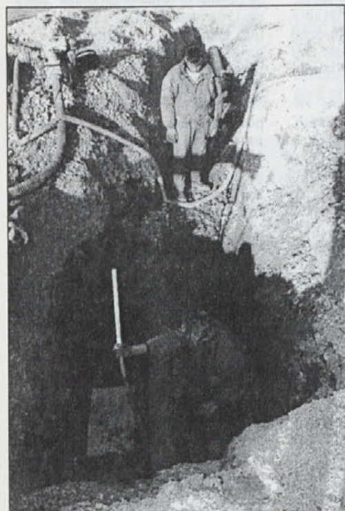
Rižanski vodovod je moral premestiti tudi glavno vodovodno cev. Zaradi tega je za kratek čas nekaj stanovalcev v Luciji ostalo brez vode.
