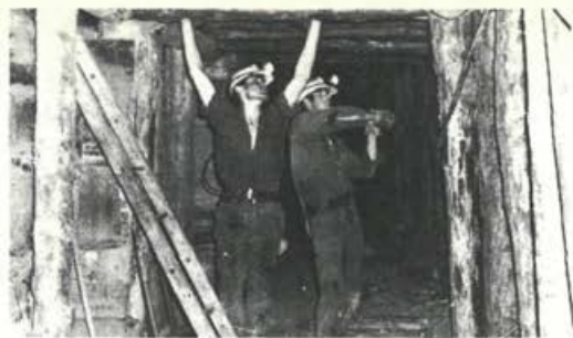
Sl. 4. Skrbno izdelano podporje (cimpranje) zagotavlja varno delo v idrijski jami. Foto: Renato Škarabot
