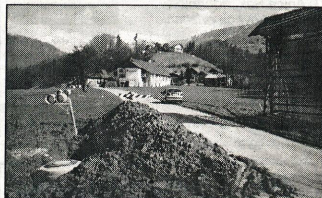
Gradnja kanalizacije od Podjelše proti Kršiču uspešno napreduje.
