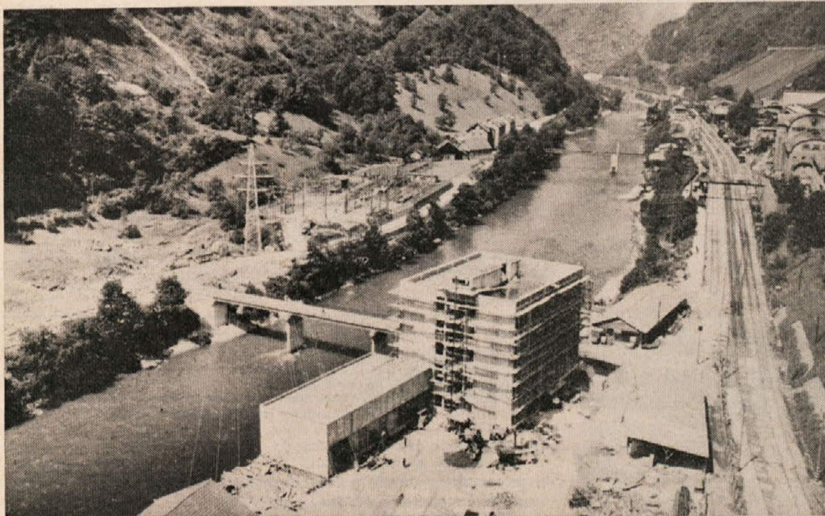
Se en detajl z gradbišča TE II v Trbovljah. Posnetek upravno tehnične stavbe s črpalščem.
