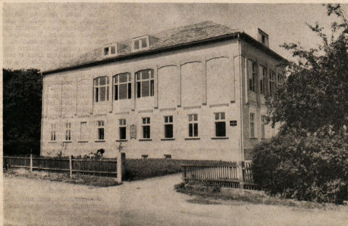
Z adaptacijo in nadzidavo 100 let stare šole v Frankolovem je ta lep kraj dobil moderno šolsko poslopje.
