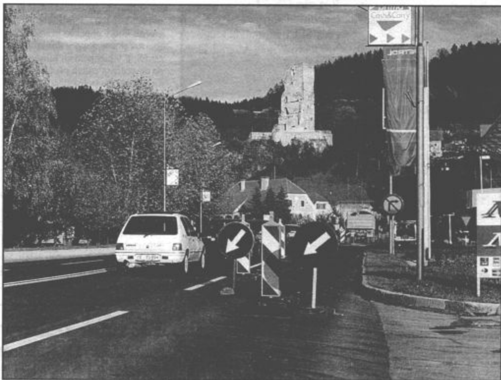
Zavijanje na Gorico je bilo zadnjih nekaj let ne le nevarno, ampak tudi zamudno. Križišče je bilo zaradi velike obremenjenosti slabo prepustno. Z novim zavijalnim pasom bo vse to preteklost.
