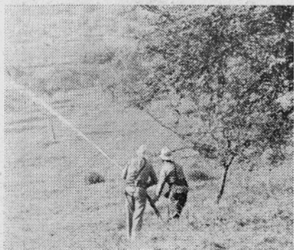
PRVA GASILSKA VAJA IZ HIDRANTOV NOVEGA VODOVODA
