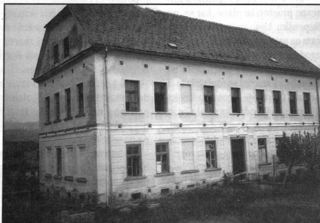
Nekdanja šolska stavba v Bočni nudi z razbitimi okni klavno podobo (foto: Savinjčan)
