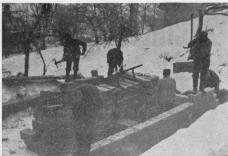
Posnetek prikazuje delavce med podiranjem nepravilno in s špekulativnimi nameni grajeno bajtico na Polulah
