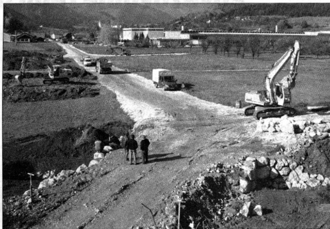
Nova cestna povezava se bo izognila zaselku Loke in bo omogočila direkten dostop do regionalne ceste (foto: EMS)
