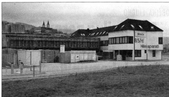
Znotraj hale trenutno poteka priprava talne plošče, izgradnja sten, zaključuje pa se tudi izdelava strehe (foto: Irena Drobež)
