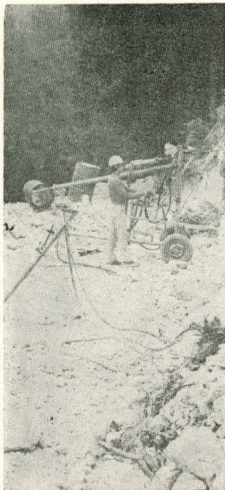
Vrtalni stroj na lafeti olajša vrtalcu težavno delo — foto: A. Šertel
