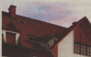
Montaža strelovodov namestitev vseh elementov za strelovode iz Cu, Alu, Fe in Zn, meritev strelovodnih napeljav, svetovanje ...
