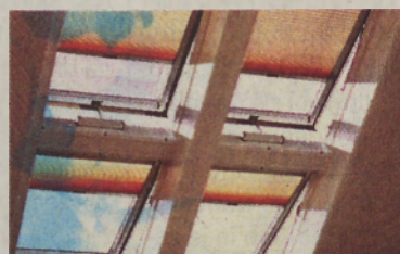
Vgraditev strešnih oken izbira strešnih oken ponuja rešitev za vse namene
