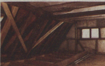
Tesarska dela zamenjava slabih špirovcev, leg, letov ...
