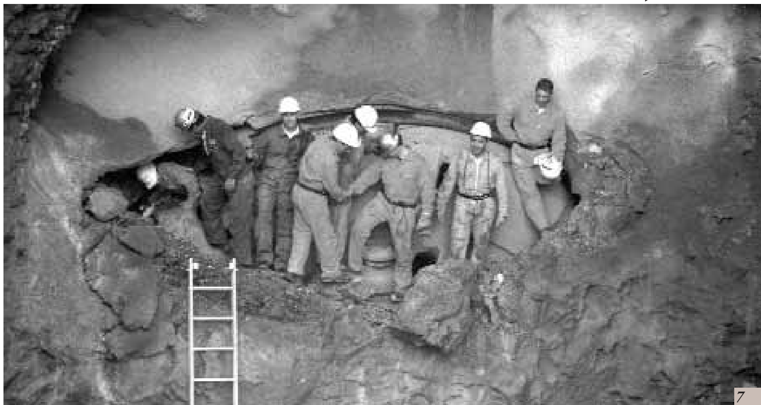
Zadnje dni junija je delavcem s pomočjo stroja TBM uspelo prevrtati dovodni tunel za HE Plave II.
