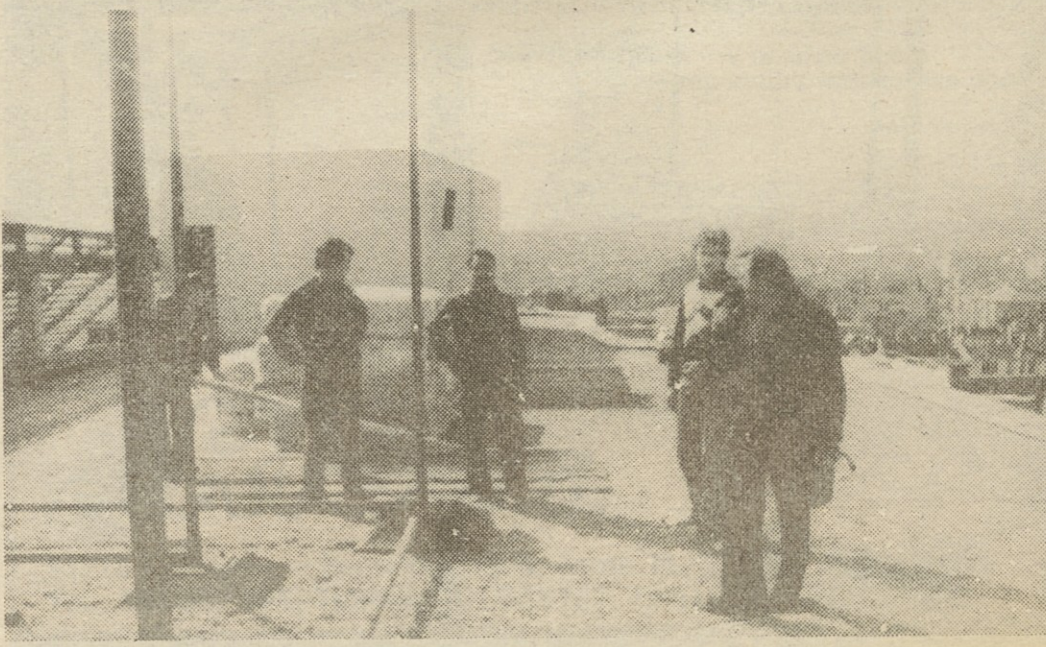
Stanko Varga, Branko Pilinger, Tone Kirbiš in Borut Perhavec med ogledom gradbišča
