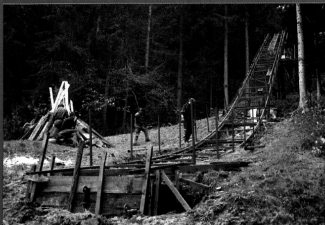
Zaradi varnosti skakalcev so na Ljubnem obnovili zaletišče na manjši skakalnici (foto: Janez Orešnik)
