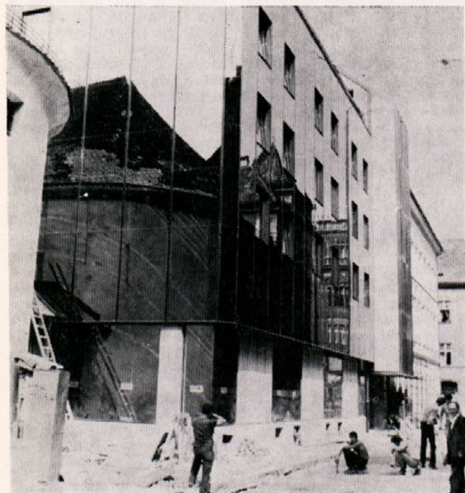
V mesecu oktobru bo odprt hotel Evropa. Delavci TOZD GO Laško hitijo z zaključnimi deli na objektu.
