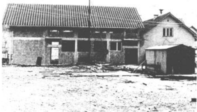
Gradnja doma naglo napreduje
