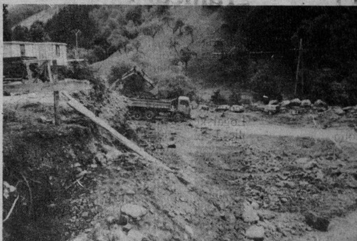
Na Ljubnem so pričeli z gradbenimi deli za nove delovne prostore Iskre—Feriti
