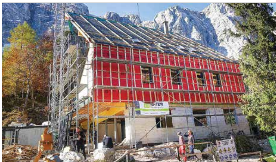
Gradnja novega planinskega doma na Okrešlju kljub zahtevnosti zaradi odročne lokacije poteka po načrtih. (Foto: PD Celje Matica)
