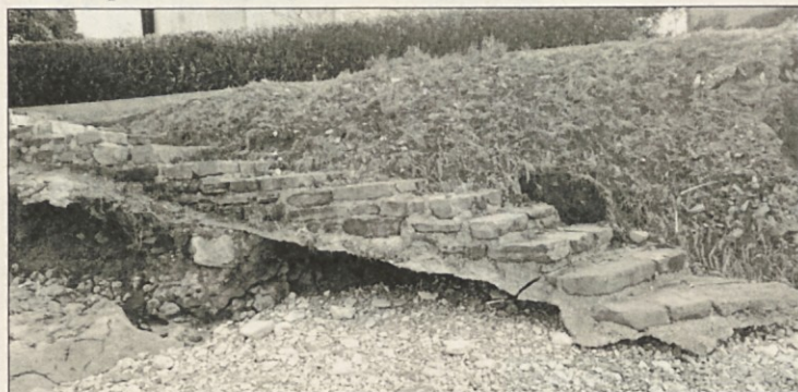
Prve kamnite stopnice drži skupaj par cm betona in sreča.
