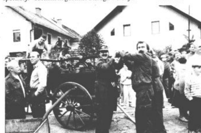
Kar urno so morali "pumpati", da je voda stekla po ceveh
