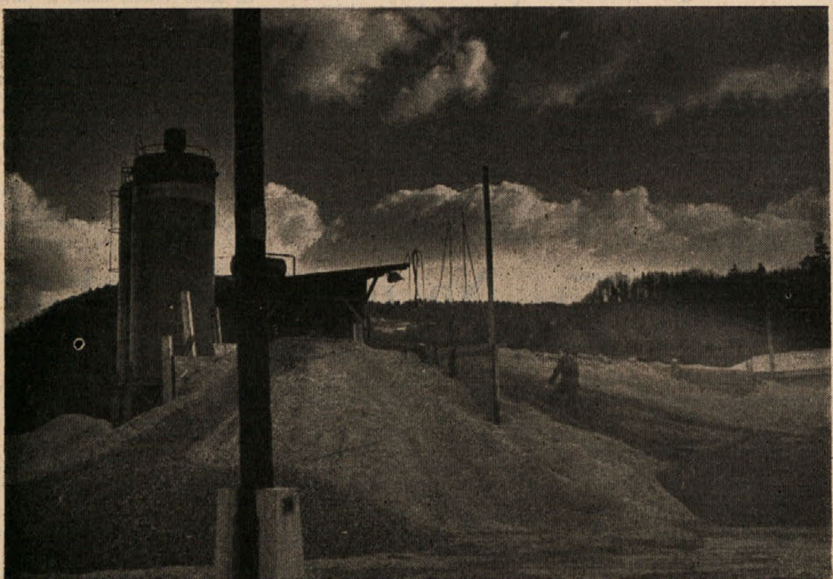
V Medlogu ob gramoznici smo postavili centralno betonarno, ki zadostuje celotnim potrebam sektorja Celje. Čeprav je objekt le provizoren in lesen, nam daje kvaliteten, visoko odporen beton. (Foto Javoršek)
