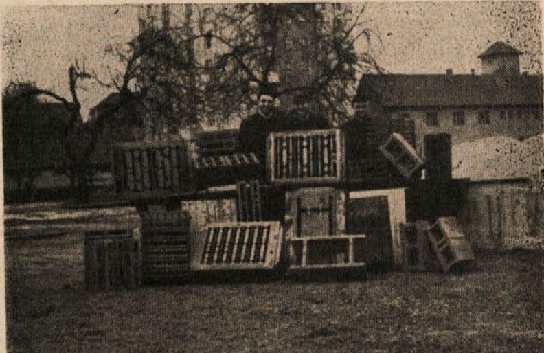
Novo nabavljeni stroj »Rosacometa« smo morali kompletirati tudi z modeli za termo, nosilne in predelne zidake. Ker pa so ti modeli v tujini izredno dragi, so nam priskočili na pomoč lastni strokovnjaki. Izdelki so cenejši in tudi kvaliteta povsem odgovarja. Čestitamo!
