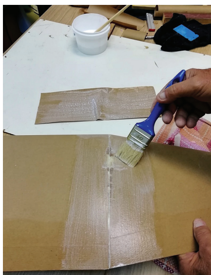
Krila na mestu spoja ojačimo z dodatnim slojem papirja
