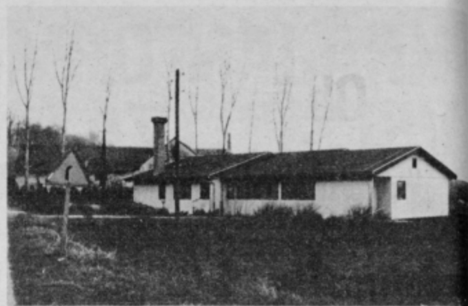
Pri otroškem vrtcu je potrebno zgraditi še igrišče
