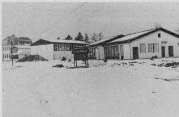
Prenovljena osnovna šola z večnamenskim prostorom—telovadnico in vrtec (v ospredju) so prav gotovo največje pridobitve
