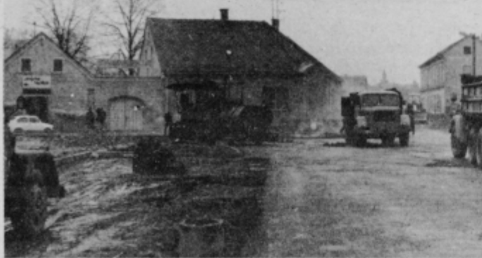
Dela pri asfaltiranju Zadružnega trga.
