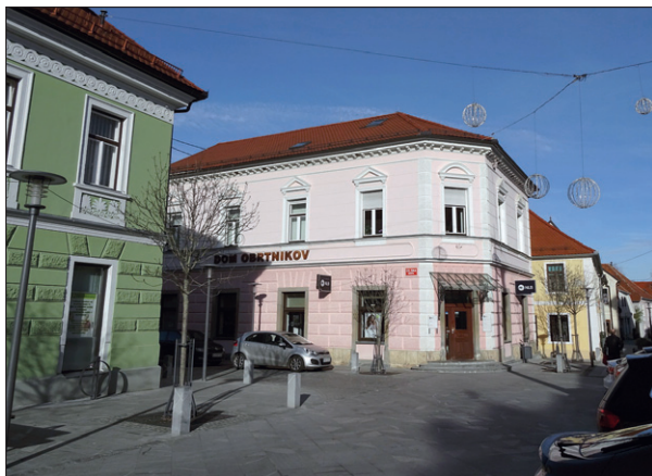
Stavba Območne Obrtno-podjetniške zbornice Slovenske Konjice v spodnjem delu Starega trga
