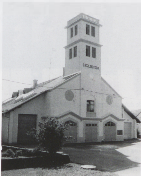
Prenovljen in razširjen gasilski dom leta 1988.
