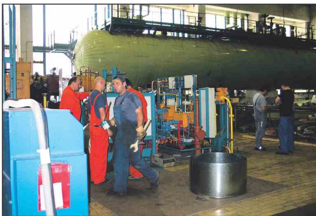
Na gradbišču se je srečevalo tudi po 1300 delavcev.
