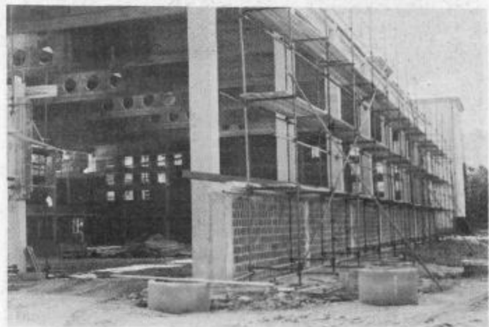
Gradbena dela bodo zaključili že v tem koledarskem letu, z novimi površinami pa zadovoljivo rešili prostorsko stisko pri izvajanju ur športne vzgoje.
