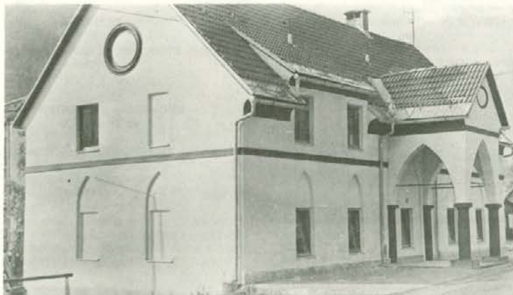
V tej stavbi so delavci Žage Mušenik uredili štiri družinska stanovanja. Hiša stoji tik ob žagi.
