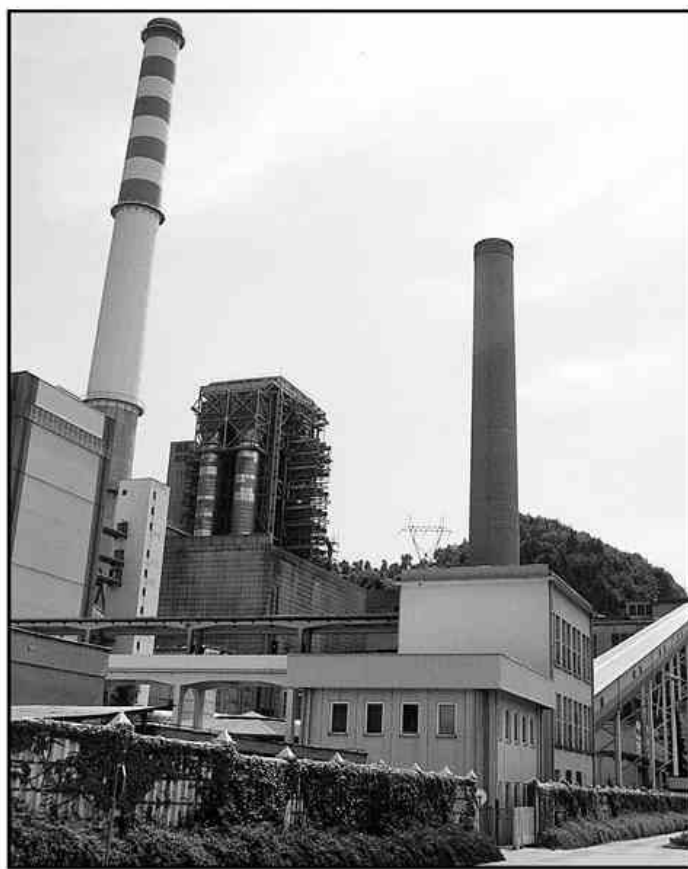
V sklopu letošnjega remonta četrtega bloka, bodo temeljito pregledali in po potrebi popravili tudi razžveplalno napravo četrtega bloka. Jeseni bodo vanjo speljali tudi dimne pline prvih treh blokov.
