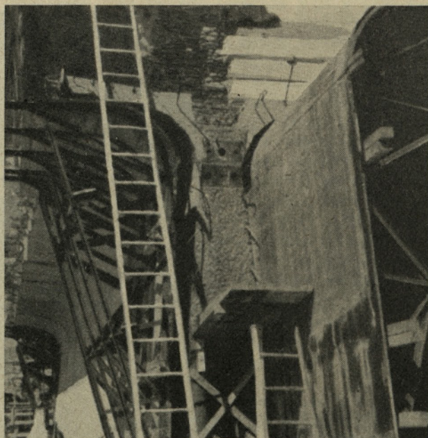
Detajl pomičnega opaža in kanal za kable
