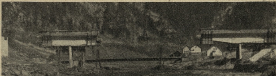
Gradnja konzol. Ob desnem bregu je viden opažni oder, ob levem pačasne lesene podpore. V ozadju stari most
