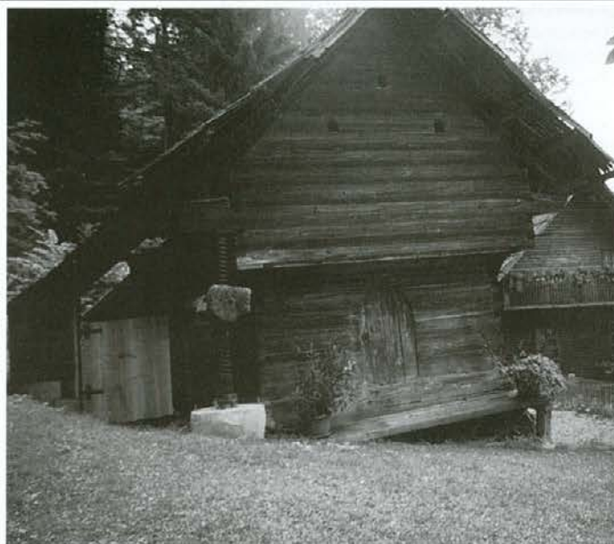
Kašča pri Ladiniku na Platu 2003.
