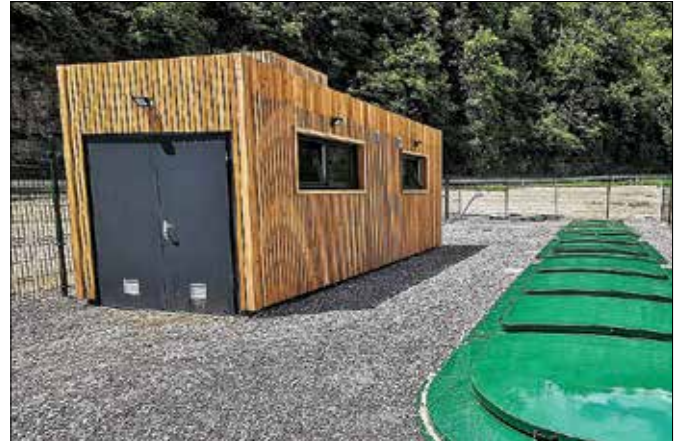
Z namestitvijo lesene fasade na objekt je poskrbljeno tudi za primeren videz, saj je naprava tik ob cesti pri vhodu v Luče.
