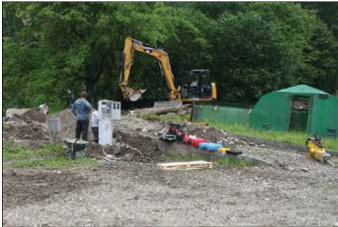
Odstranjevanje stare čistilne naprave in izravnava terena
