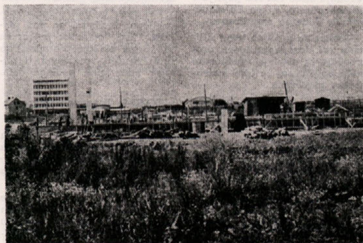
Obrat AC papirja v začetni fazi gradnje
