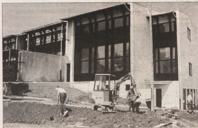
DELA SE ZAKLJUČUJEJO - Včeraj, 13. junija, je bil tehnični pregled prizidka, ob nastanku pričujoče fotografije pa so delavci hiteli z urejanjem njegove okolice. (Foto: M. Ž.)
