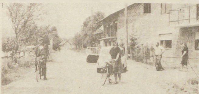
Ko smo bili v Motvarjevcih, je skozi ta del vasi že bilo pripravljeno cestišče za asfaltno prevleko in domačini so že bili boljše volje, saj se bodo končno znebili prahu.
