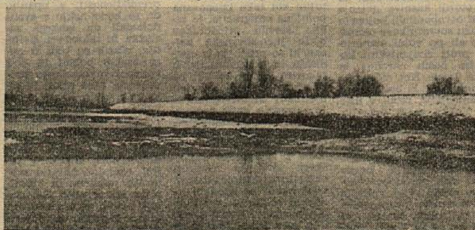
Del novega nasipa na desnem bregu Save, ki ščiti pred poplavno vodo Čateške Toplice
