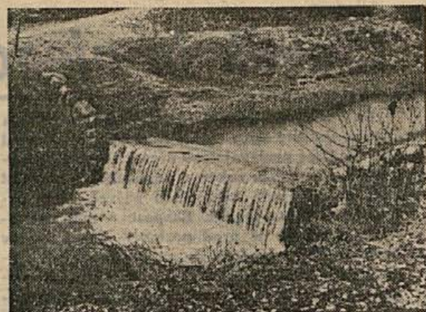
Takšen je hudournik po regulaciji. Obe brežini sta dovolj visoki, da se voda ne more razliviati preko bregov; zajeza, kot jo vidite na sliki, pa zmanjšuje silovitost toka
