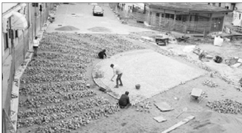
Gradbišče na trgu pred županstvom
