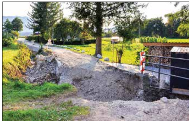
V Spodnji Rečici pri baru Lisjak poteka gradnja mostu in obnova cestnega odseka.
