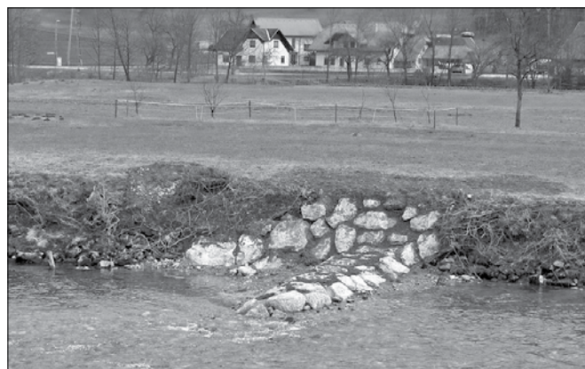
Na Dreti ob Žlabru so delavci Nivoja očistili prodišče ter izdelali jezbice, ki bodo preprečevale formiranje novih prodišč. (Foto: IS)
